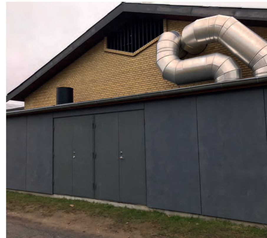
Teknikbygningen til ventilationsaggregater
